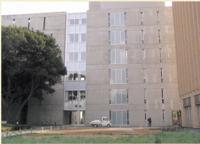
中央ガラス張りより右側が新1号館 左側は従来の大学8号館
