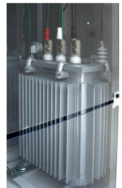
トップランナー変圧器（右）とそれを格納したキュービクル（上）
